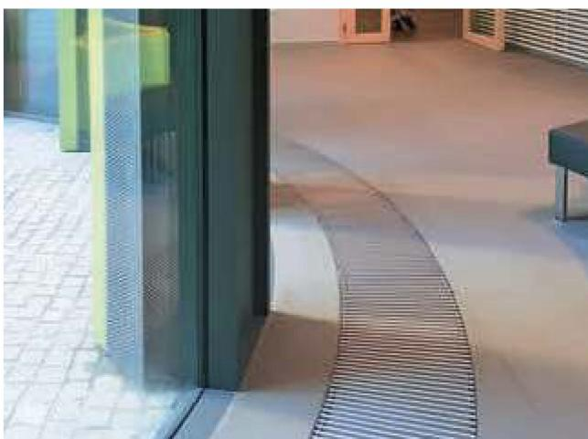
В современных зданиях с изогнутым остеклением по индивидуальному запросу возможно изготовление дугообразных конвекторов как с естественной, так и с принудительной конвекцией. Изгиб должен повторять линию остекления. Размеры внутрипольного конвектора необходимо определить на месте, поскольку реальная планировка часто не соответствует проекту.
